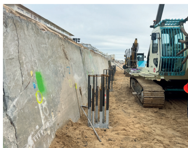
Un nouveau mur est érigé et adossé au soutènement historique.
